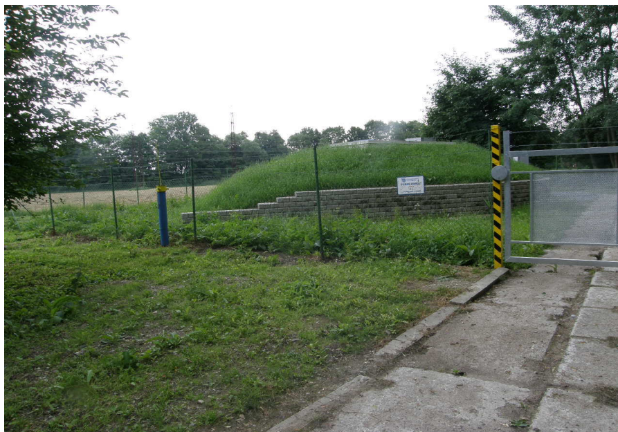
Obr.1.1. Ochranné pásmo I. stupně jímání podzemních vod (nadzemní manipulační šachtice nad studnou v oploceném jímacím území - archiv S. Šeda)
