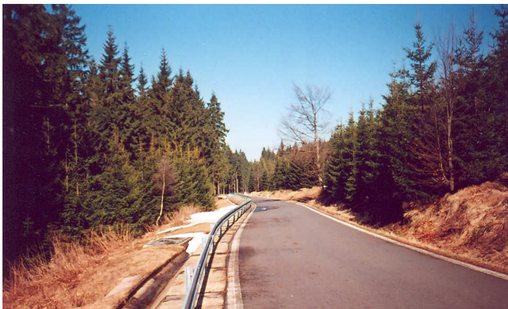
Obr. 2.3. Záchytné nepropustné příkopy zaústěné do záchytné jímky (foto P. Maršalko)
