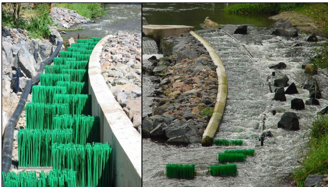
Obr. 5 Balvanitý a kartáčový RP umístěné ve dvou tratích vedle sebe, řeka Fulda, Německo (foto Dr. Ing. R. Hassinger)
