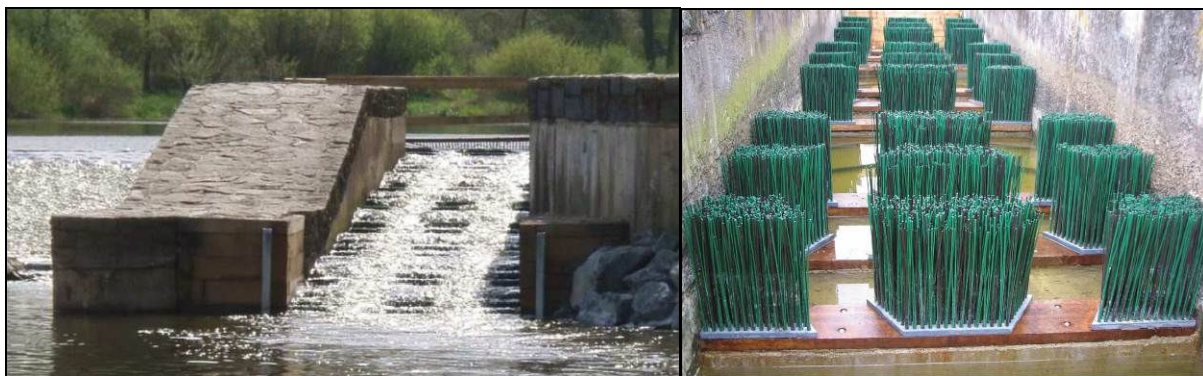
Obr. 6 Aplikace kartáčové technologie v jezové propusti (profil Budín, Sázava)
