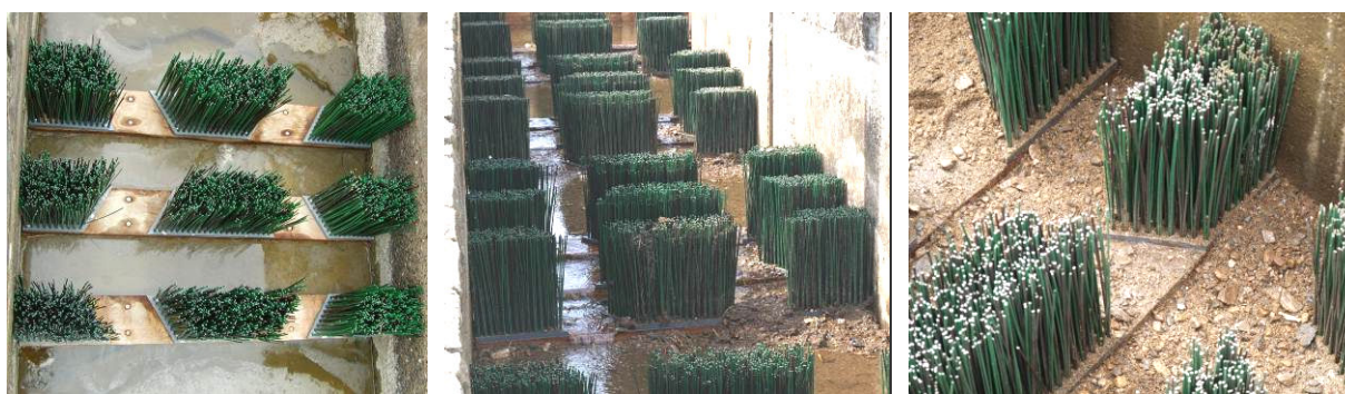
Obr. 1 Fotografie instalovaných kartáčů v profilu Budín na řece Sázavě
