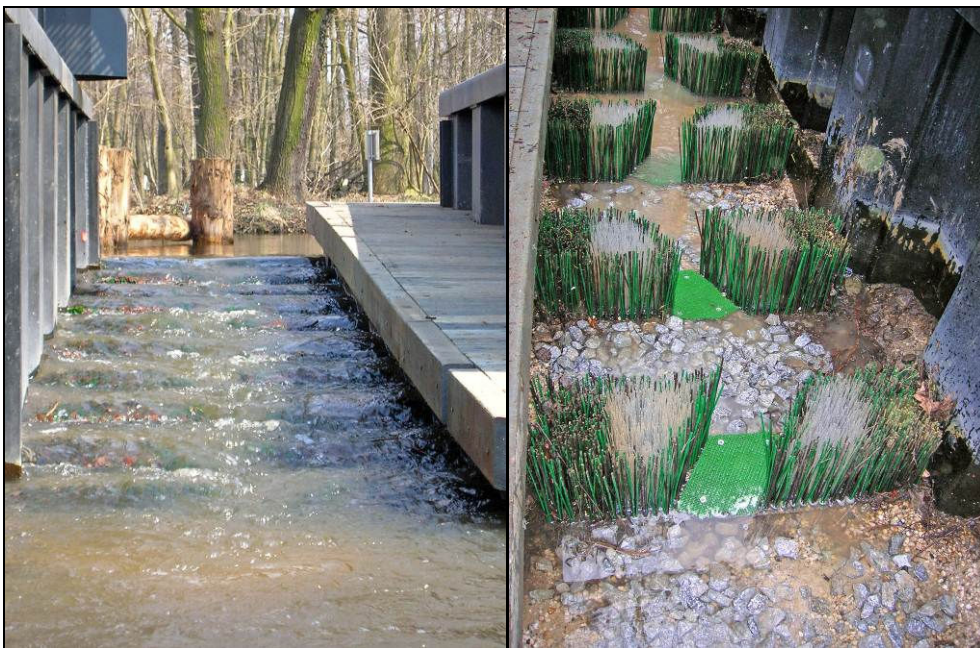
Kartáčový rybí přechod s využitím různých typů prutů v jednom bloku, řeka Spréva, Německo (foto Dr. Ing. R. Hassinger)
