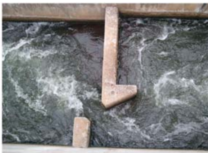
Obr. 10.13 Jednoduché štěrbinové rybí přechody – a) standardní, b) meandrový
