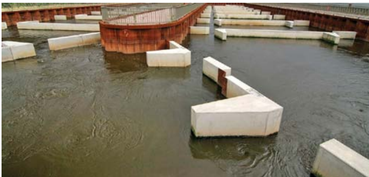
Obr. 10.23 Změna směru ve štěrbinovém RP na VD Geesthacht na Labi (Německo)
