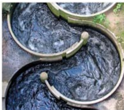
Obr. 10.22 Realizace štěrbinového – meandrového RP na VD Drakenburg (Weser, Německo)
