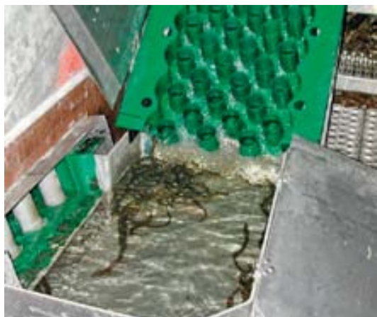
Obr. 10.39 Řešení změny směru žlabu mezilehlým bazénkem na přechod Beauharnois na řece St. Lawrence (Kanada) podle společnosti Milieu inc. (Kanada), publikováno se souhlasem
