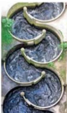
Obr. 10.22 Realizace štěrbinového – meandrového RP na VD Drakenburg (Weser, Německo)
