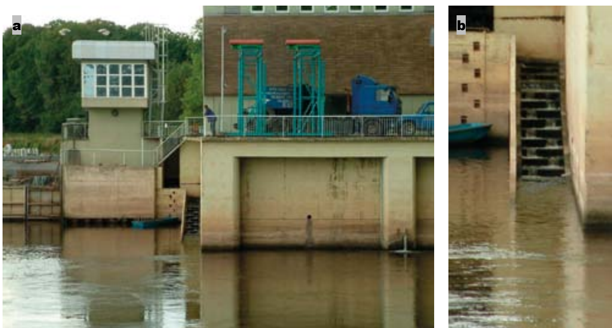
Obr. 13.2 Vodní elektrárna na jezu v Obříství s nevhodně umístěným rybím přechodem (a) a detailem vstupního otvoru (b) viditelně bez lákavého proudu, který by ryby mohly nalézt.
