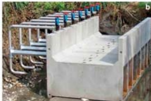
Obr. 9.13 Převádění přídavného průtoku z koryta v dolní vodě Venturiho trubicí podle návrhu University Kassel (SRN); (a) schématický podélný řez, (b) prefabrikovaná baterie trubic; publikováno se souhlasem
