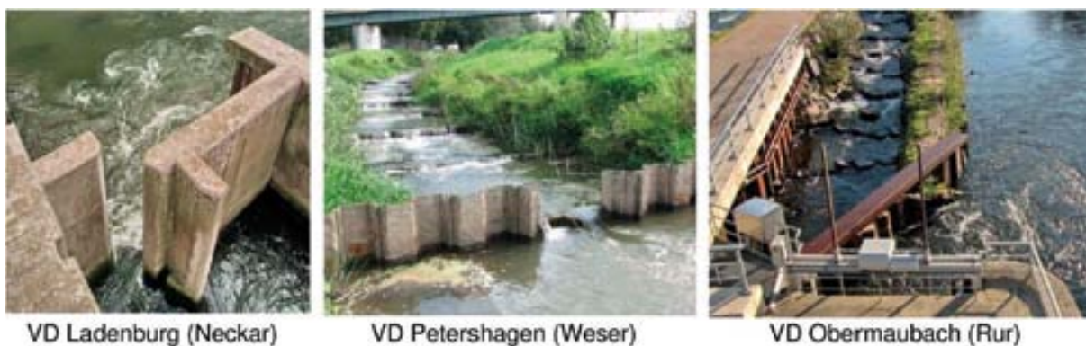
Obr. 9.15 Příklady zúžení průtočného profilu na vstupu RP
