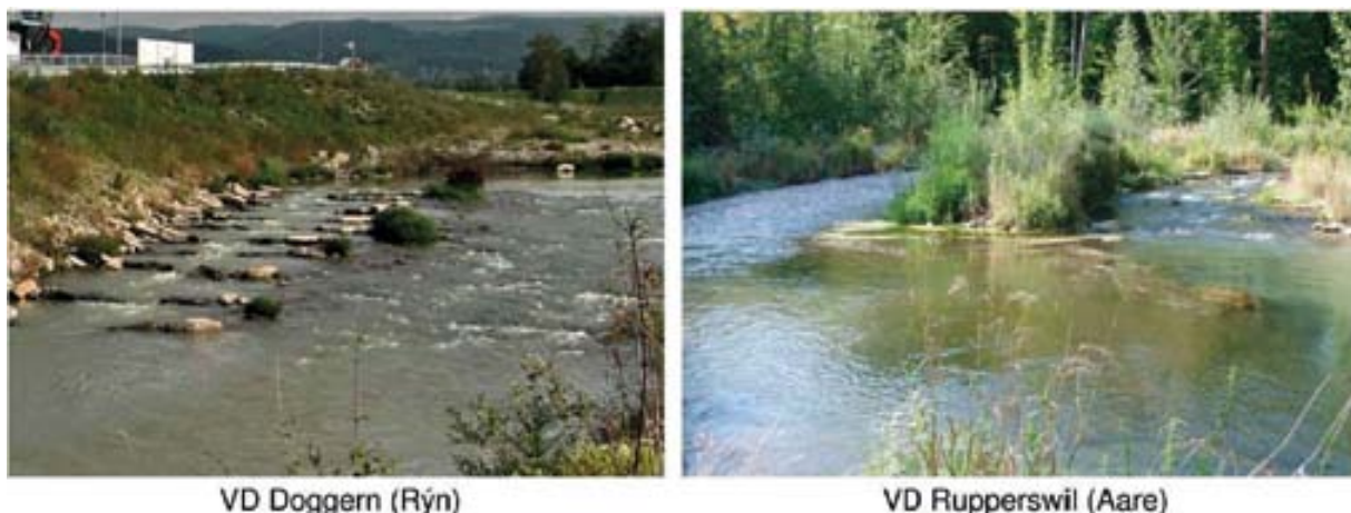
Obr. 10.11 Příklady kombinace bazénové balvanité tratě (s liniemi balvanů při pravém břehu) a plochého balvanitého drsného skluzu (Švýcarsko)
