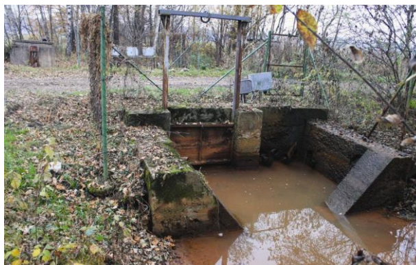
Obr.3 Aktuální stav odvodňovací čerpací stanice s přeložením ponorných čerpadel ze šachet do vodní zdrže.
