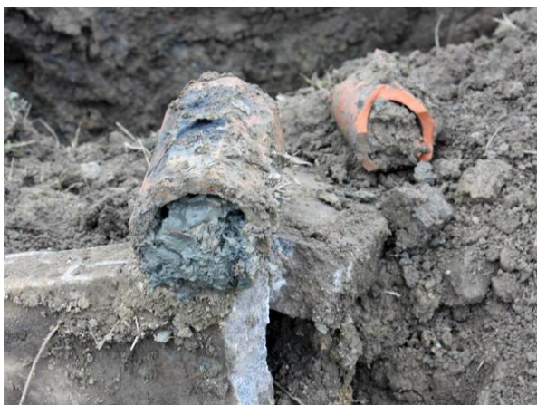
Obr.2 Příklady částečného nebo úplného zanesení drénů zemíými částicemi. U částečného zanesení drenážní prvek nadále plní odvodňovací a transportní funkci v závislosti na rozsahu zmenšení světlosti drenážního potrubí. Jiné důsledky zanesení jsou u drénů sběrných a jiné u drénů svodných, do kterých přitéká drenážní voda z výše ležících, plošně rozsáhlejších, částí systému. Foto: Z.Kulhavý, M.Čmelík
