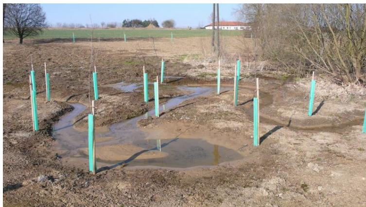
Obr.2 Odtrubnění HOZ provedené jako revitalizace vodního toku a vytvoření přírodě blízkého koryta s řadou tůní. Realizace v obci Domašín - Vlašim, okr.Benešov (realizace AOPK, v letech 2009-11). Foto: T.Just
