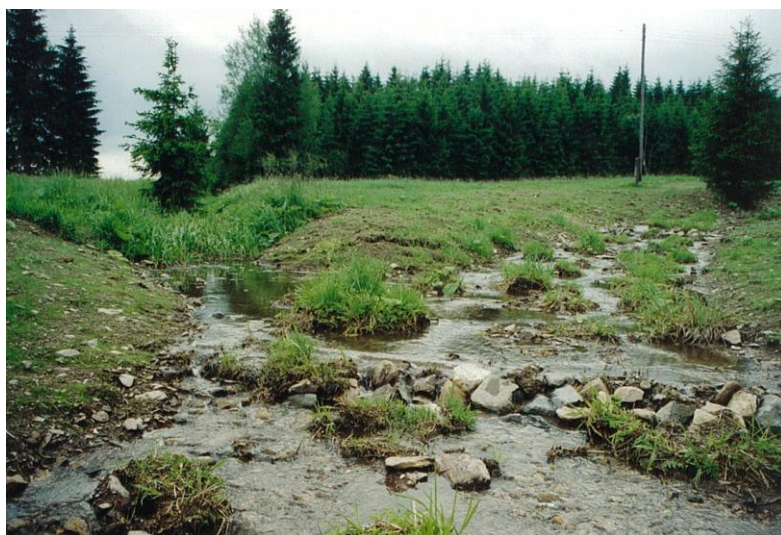
Obr.2 Funkci rozdělovacího objektu plní jakékoli stabilní či ovladatelné vzdouvací zařízení (příklady provedení příčného objektu na obrázku), pokud je před ním provedeno odbočení pro převod vody. Revitalizace Orlické Záhoří (ZVHS). Foto: Z.Kulhavý Vlevo: Příčná přehrážka z dřevěných povalů Vpravo: Bariéra vytvořená z kamene, odklánějící část průtoku do navlažovacího ramene koryta vodního toku (zde nejde o soutok vodotečí)
