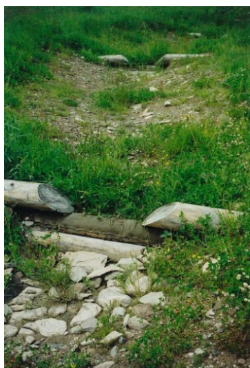
Obr.2 Funkci rozdělovacího objektu plní jakékoli stabilní či ovladatelné vzdouvací zařízení (příklady provedení příčného objektu na obrázku), pokud je před ním provedeno odbočení pro převod vody. Revitalizace Orlické Záhoří (ZVHS). Foto: Z.Kulhavý Vlevo: Příčná přehrážka z dřevěných povalů Vpravo: Bariéra vytvořená z kamene, odklánějící část průtoku do navlažovacího ramene koryta vodního toku (zde nejde o soutok vodotečí)
