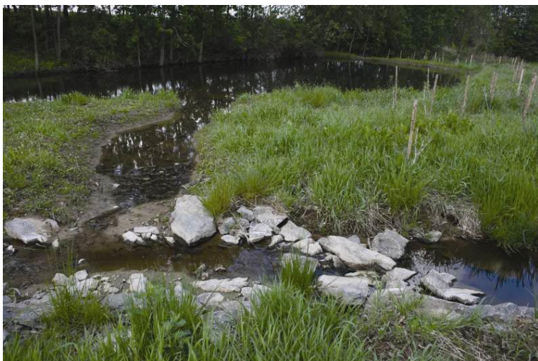
Obr.1 Rozdělovací objekt s přirozeným charakterem realizace, sloužící k odklonu vody pro zásobování boční tůně. Okr. Rychnov n. Kněžnou. Foto: Z.Kulhavý
