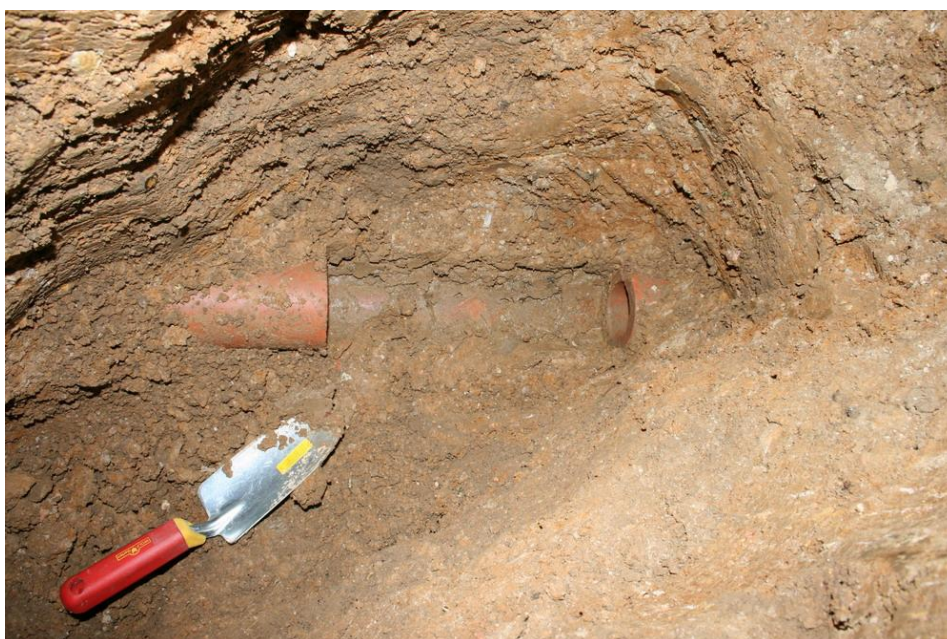
Obr.1 Odkrytí drénu po jeho vytyčení. Odebrání drenážky z pálené hlíny. Foto: Z.Kulhavý
