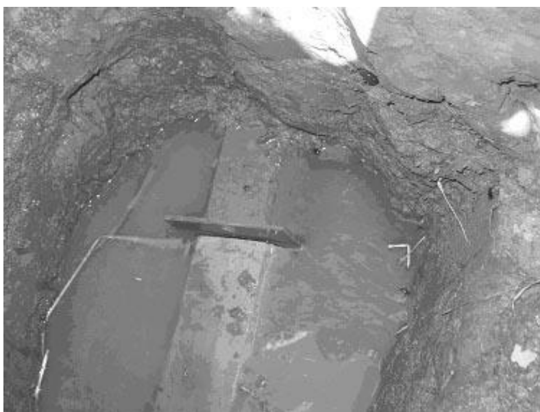
Obr.2 Příklad instalace záslepky na drénu, kdy je záslepka vložena do stávajícího drénu o průměru 0,13 m. Foto M. Soukup
