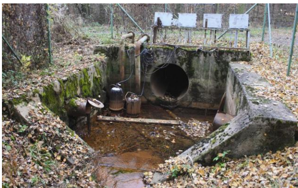
Obr.3 Aktuální stav odvodňovací čerpací stanice s přeložením ponorných čerpadel ze šachet do vodní zdrže.
