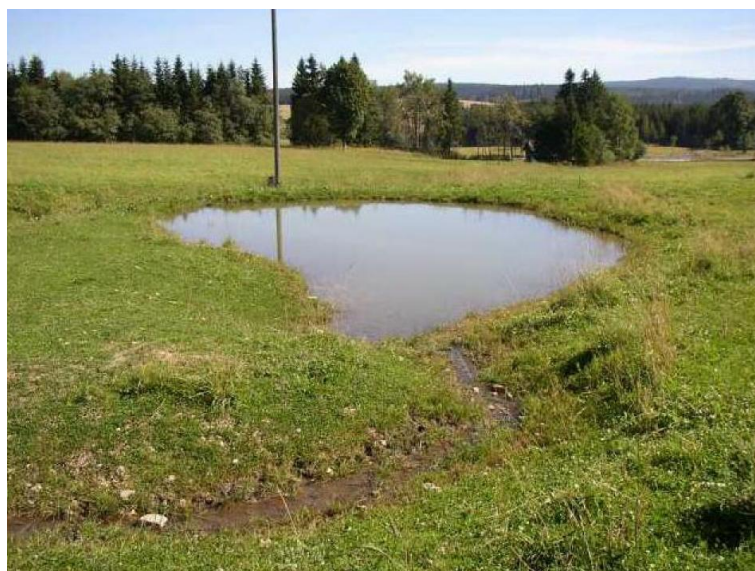
Obr.1 Revitalizace drobného vodního toku u obce Orlické Záhoří, okr. Rychnov n. Kn. (ZVHS, 2003) realizovaná na pozemcích odvodněných drenáží. Nahoře: Letecké snímky před realizací (rok 2003) a po realizaci (2009): Zdroj: www.mapy.cz Dole: Pohled na realizovanou boční tůň. Foto: H. Vondrušková
