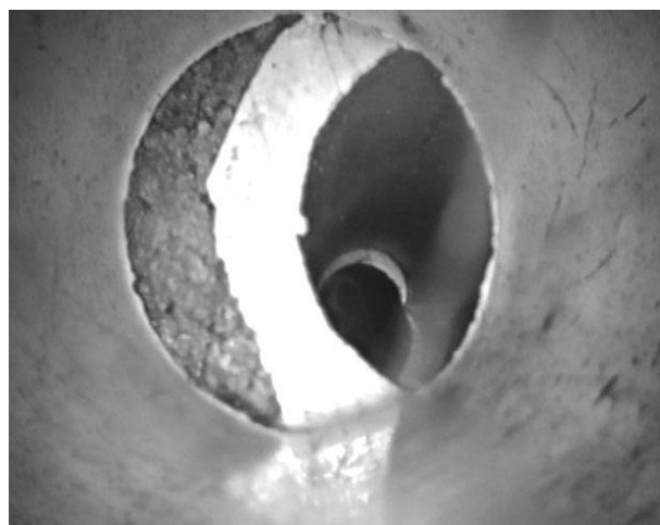
Borcení klenby (podélné, příčné) a rozpad materiálu potrubí (pálená hlína)
