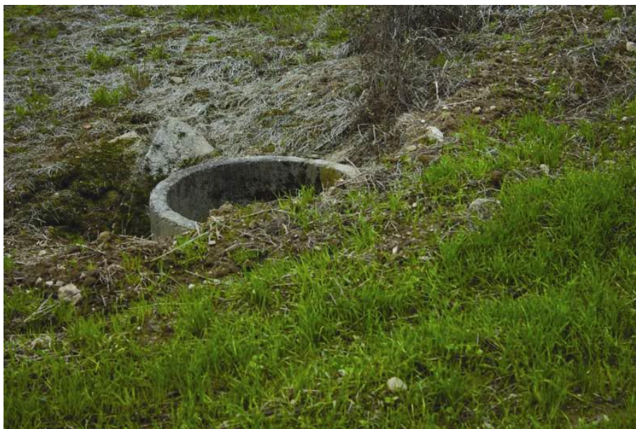
Foto 1-5 Eroze půdy v místě drenážní šachtice, způsobená špatnou údržbou a agrotechnikou. Okres Cheb. Autor: M.Čmelík
