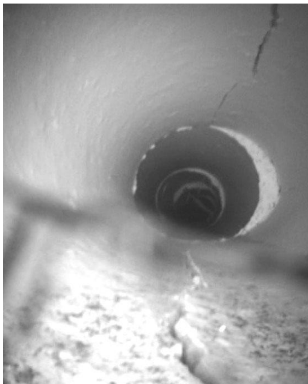
Borcení klenby (podélné, příčné) a rozpad materiálu potrubí (pálená hlína)
