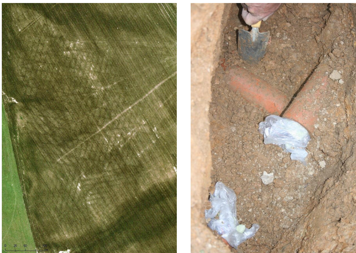
Obr.2-2 Příklad doložení dvou drenážních systémů nad sebou (lokalita Maleč, okr. Havlíčkův Brod), identifikovaných prostředky DPZ (vlevo). Ověření existence dvou etáží vytyčením místa křížení a odkopáním až na úroveň obou drénů (vpravo). Foto: Z.Kulhavý
