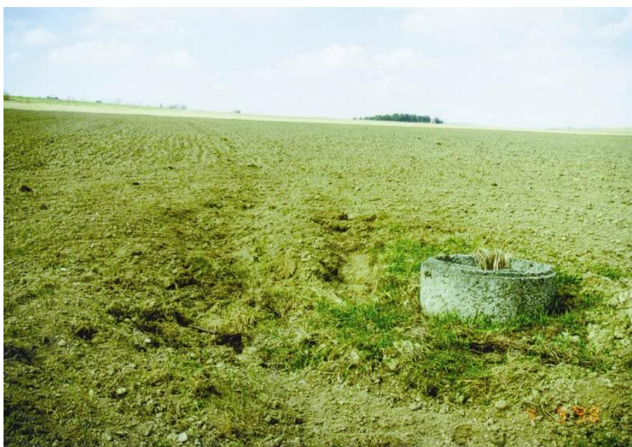
Foto 1-6 Eroze zemědělské půdy vyvolaná na svahu situováním drenážní šachtice a nevhodnou agrotechnikou bezprostředního okolí šachtice. Okres Bruntál. Autor: Z.Kulhavý
