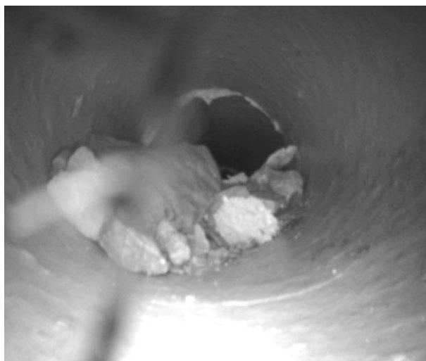
Snížení průtočného profilu vplaveným hrubozrnným kamenivem
