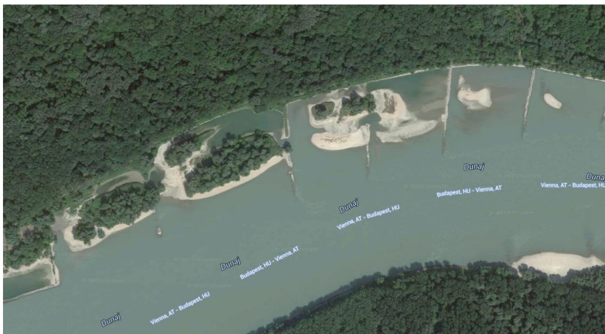
Obr. 44 Upravené výhony, říční pláže a částečně ponořené štěrkové lavice na březích Dunaje nedaleko Witzelsdorfu (Rakousko)
