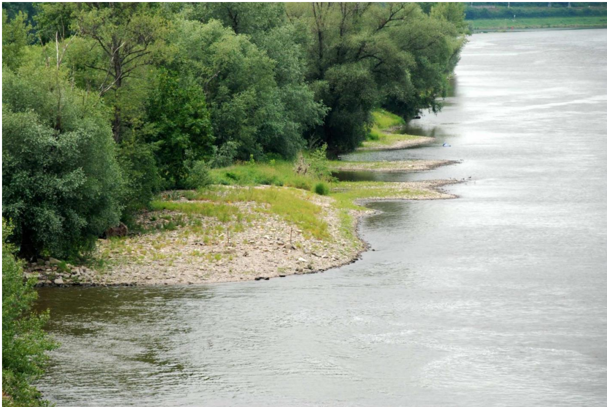
Obr. 57 Šterkové lavice vybudované z materiálu získaného z prohrábky vodní cesty
