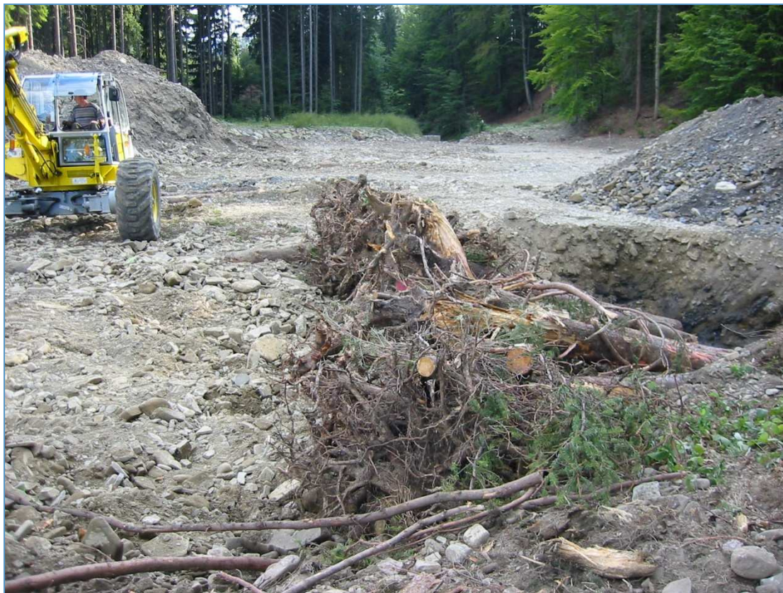
Obr. 2.2.10 Instalace stabilizace konkávních oblouků - kmeny s ponechaným kořenovým balem.
