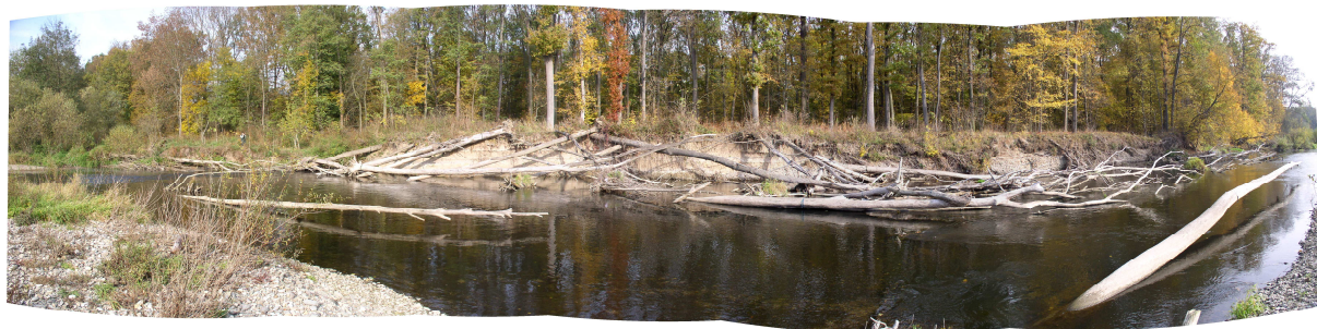
Obr. 2.2.19 Panoramatický snímek meandru M4. Kmeny v blízkosti nárazového břehu byly vyvráceny a korunou orientovány do koryta. Na tomto snímku z října 2006 mají kmeny téměř totožnou polohu jako při ukotvení v roce 2003. Kmeny v popředí a uprostřed koryta jsou na lokalitě původní a nebyly předmětem stabilizace. (foto: P. Kožený)
