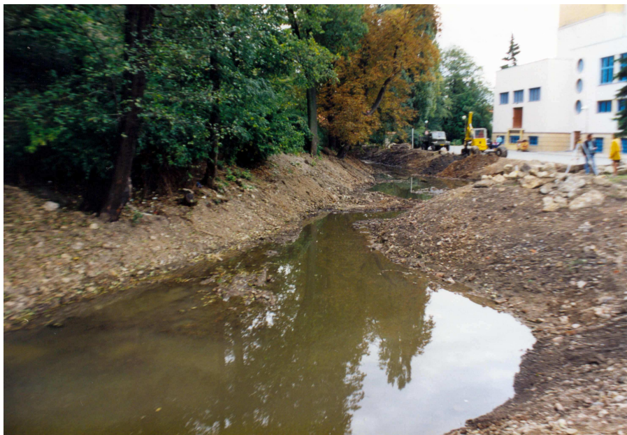
Obr. 2.2.2 Náhon v průběhu realizace – rozšiřování nivy.
