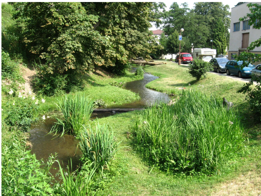
Obr. 2.2.6 Náhon „U divadla“ po revitalizaci, rok 2010; začlenění revitalizovaného úseku do architektury města, probíhá vývoj vegetace, dřevní hmota v konkávních březích je prakticky zcela zarostlá bylinnou vegetací, dochází k zmlazování druhů měkkého luhu, které doplňují stabilizaci kořenovým systémem. Sukcese je antropicky ovlivněna.
