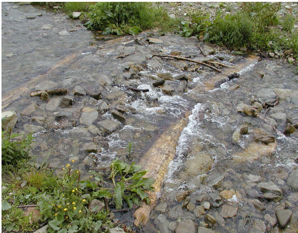
Obr. 2.2.12 Stabilizace brodů pomocí dnových dřevěných pasů.
