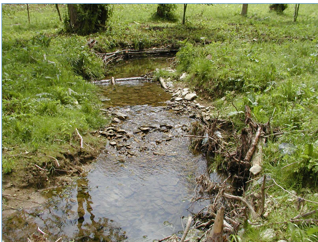
Obr. 2.2.15 Revitalizované koryto Lubenského potoka průchodu velké vody.
