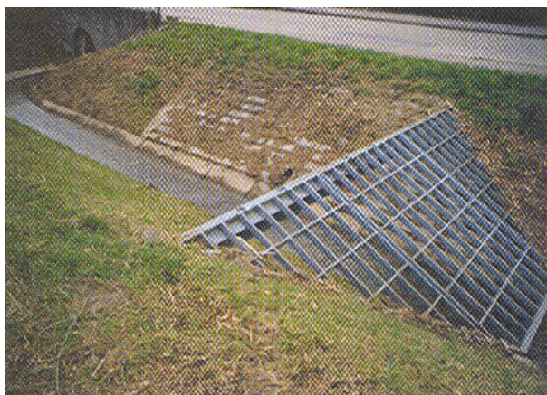
Obr. 4.3.7 Další možnost zachytávání pláví před mostním objektem (Gerhard a Reich, 2001).
