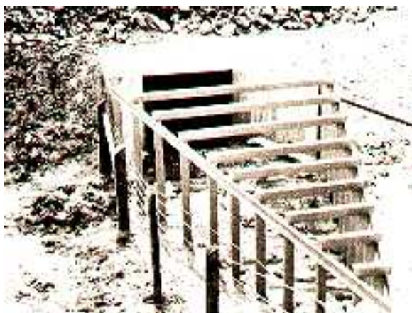
Obr. 4.3.6 Deflektor pláví před propustkem.
