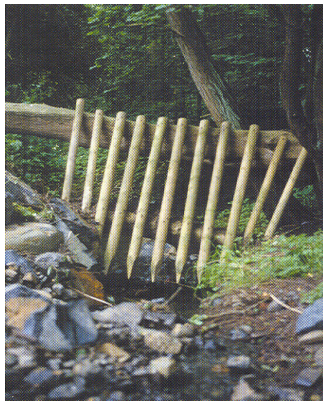
Obr. 4.3.8 Dřevěná příčná stavba (Gerhard a Reich, 2001).
