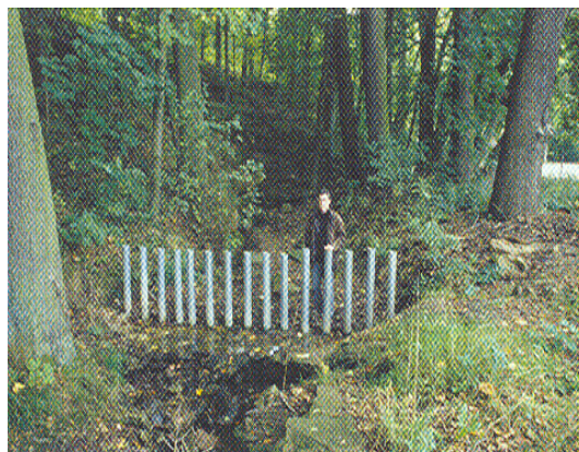
Obr. 4.3.9 Ocelové sloupky v korytě (Gerhard a Reich, 2001).
