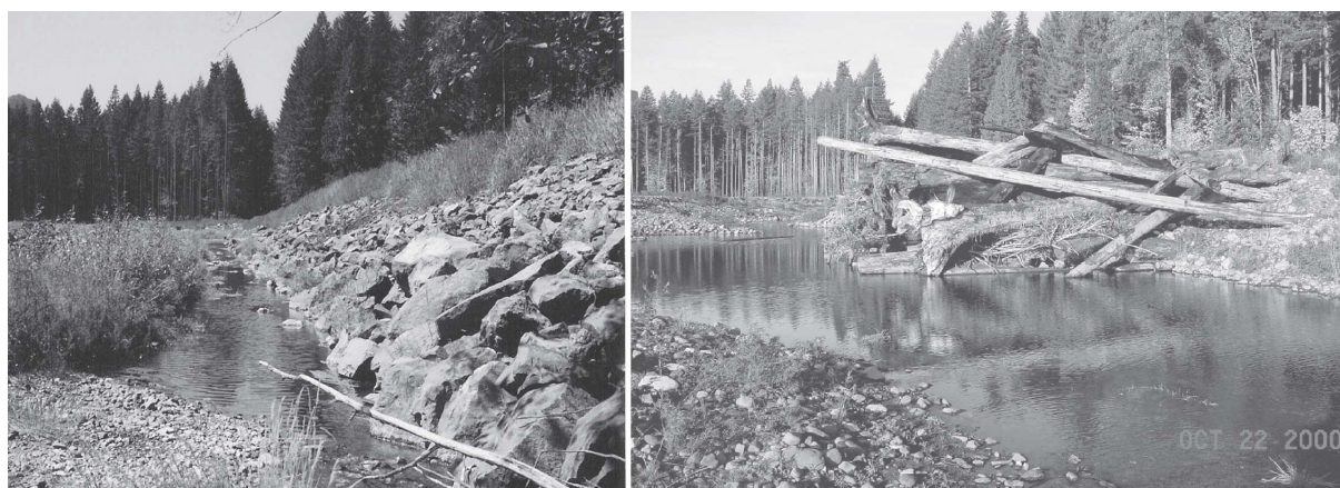
Obr. 5.3.2.2-3 Fotografie využití prvku pro ochranu břehu komunikace v USA. Na levém obrázku břeh před akcí chráněn kamenným záhozem a rovnaninou, fotografie vpravo je po realizaci. V případě použití v místech ledochodů je vhodné kulatiny směřovat tak, aby kladly co nejmenší odpor a konce orientované do středu koryta vetknout do dna.
