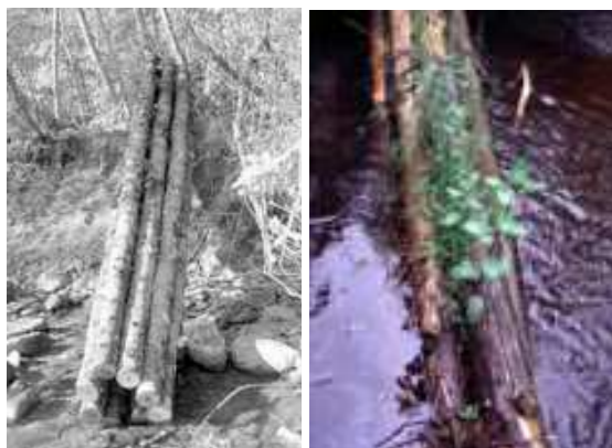
Obr. 5.3.1.1-3 Drobný výhon z dutého válce je prvek používaný v těžko dostupných oblastech bez přístupu mechanizace. Fotografie dole vlevo je pořízena před uložením do koryta a naplněním místním materiálem. Fotografie dole vpravo je pořízena po instalaci (navrženo a provedeno společností ELWd Systems, USA)
