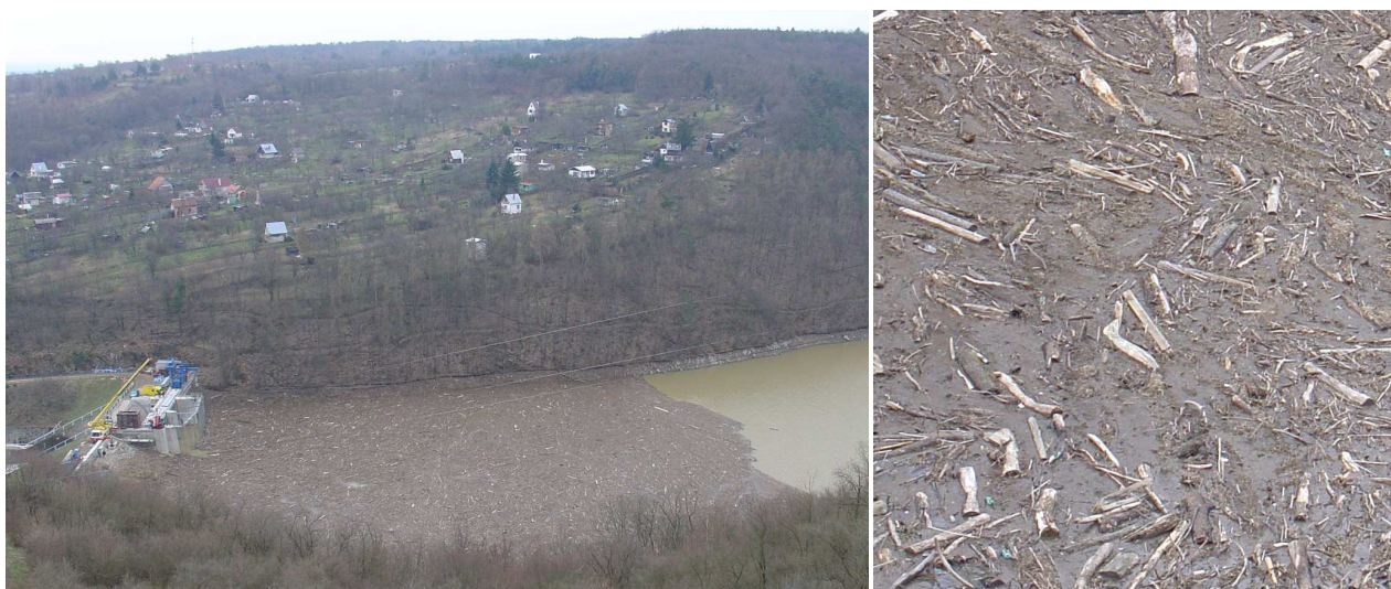
Obr. 4.4.3.1-2 Splávi nahromaděné u hráze vodní nádrže Znojmo po více než stoleté povodni na jaře 2006. Většinu dřevní hmoty tvořily 1-2 metry dlouhá polena pocházející pravděpodobně z údržby břehových porostů v NP Podyjí.
