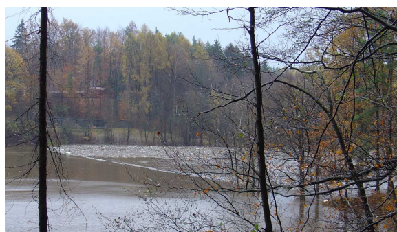
Obr. 5.6.1.7 Spláví zachycené plovoucí stěnou ze spojených klád (vodní nádrž Les Království po méně než jednoleté povodni, 2006) foto: P. Kožený.
