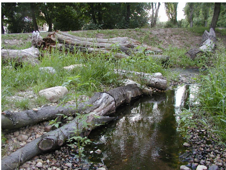
Obr. 5.4.2.3 Fotografie opevnění břehu kmeny malého vodního toku. Kotvení kmenů je provedeno vetknutím do terénu piloty. U malých koryt, kde hmota kmene s dostatečným průměrem pokrývá břeh, není nutný klestový podklad.
