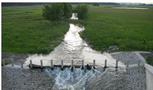
Obr. 5.6.1.6 Železobetonové sloupky tvořící hrubé česle. Základová výpust poldru Žichlínek 2009, Pardubický kraj. Foto Roman Bárta
