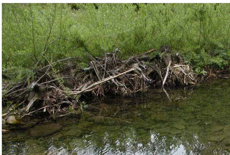
Obr. 5.4.1.2 Fotografie detailu využití opěvnění břehů s ozeleněním prvku vzrůstající dřevinou vegetací. U prvku se tvoří tůň s větší hloubkou vodního sloupce a krytové příležitosti pro živočichy, zejména ryby.
