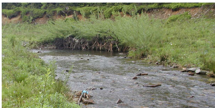
Obr. 5.4.1.3 Fotografie úseku s opěvněním břehů dřevní hmotou a vzrůstající dřevinou vegetací.
