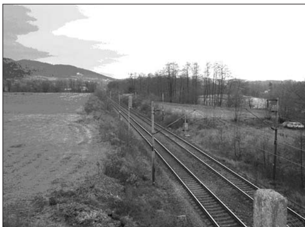
Foto č. 2: Pohled z lávky pro pěší v Bystřici nad Olší (drážní km 304,319) na stávající trať. V km 304,200 až 304,500 dojde k posunu trati o max. 3,74 mb vpravo (vztaženo ke směru staničení). Na fotografii jde o posun vlevo.
