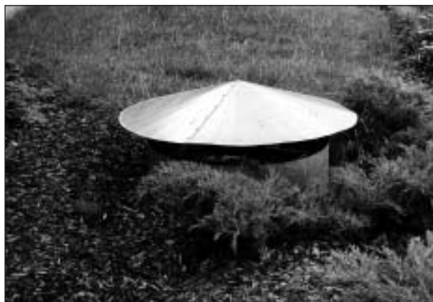
Obr. 3 – Nasávání čerstvého vzduchu do zemního kolektoru
