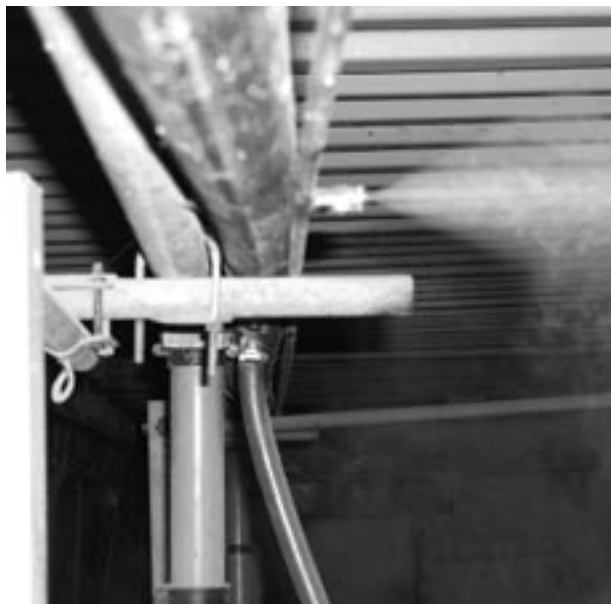
Obr.č. 2 Pohled na trysku vysokotlakého rozmlžovacího zařízení
