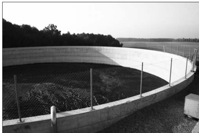
Foto 4: Skladovací jímka digestátu – zemědělská BPS Chotýčany
