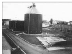
Foto 1: Zemědělská bioplynová stanice Trhový Štěpánov
