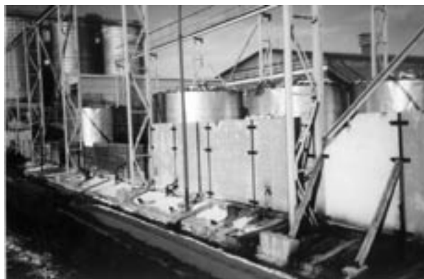
Obr. 10: Bioplynová stanice na suchou fermentaci chlévské mrvy s reaktory typu „koš-zvon“ – a.s. LUHA Jindřichov u Hranic na Moravě
