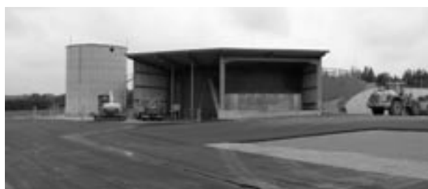
Obr. 6: Zemědělská bioplynová stanice Utzenaich – Rakousko
