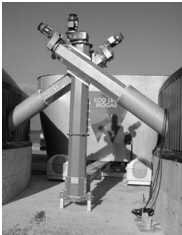
Obr. 9: Dávkování vysokosušinnového materiálu do reaktoru
