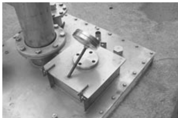
Obr. 15: Tlaková pojistka reaktoru bioplynové stanice – Rakousko
