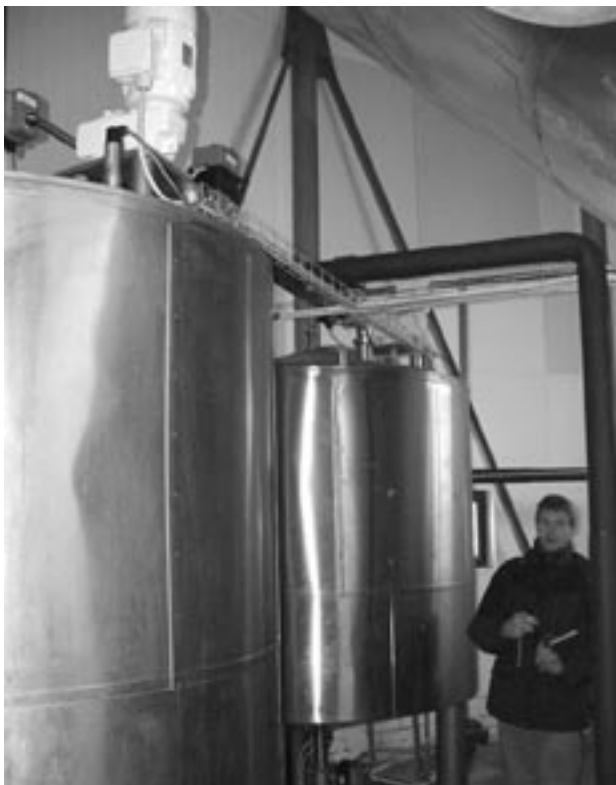
Obr. 8: Hygienizační zařízení, které je součástí bioplynové stanice Trhový Štěpánov
