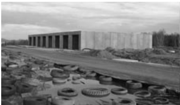
Obr. 12: Z výstavby bioplynové stanice „garážového typu“ – ČR
