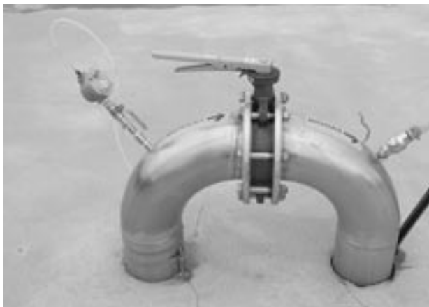
Obr. 13: Soustředné uspořádání dvou reaktorů s mezofilním a termofilním teplotním režimem, přepouštění bioplynu mezi reaktory.
