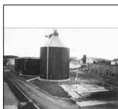
Foto 1: Zemědělská bioplynová stanice Trhový Štěpánov
