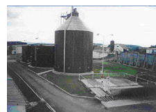
Foto 1: Zemědělská bioplynová stanice Trhový Štěpánov
