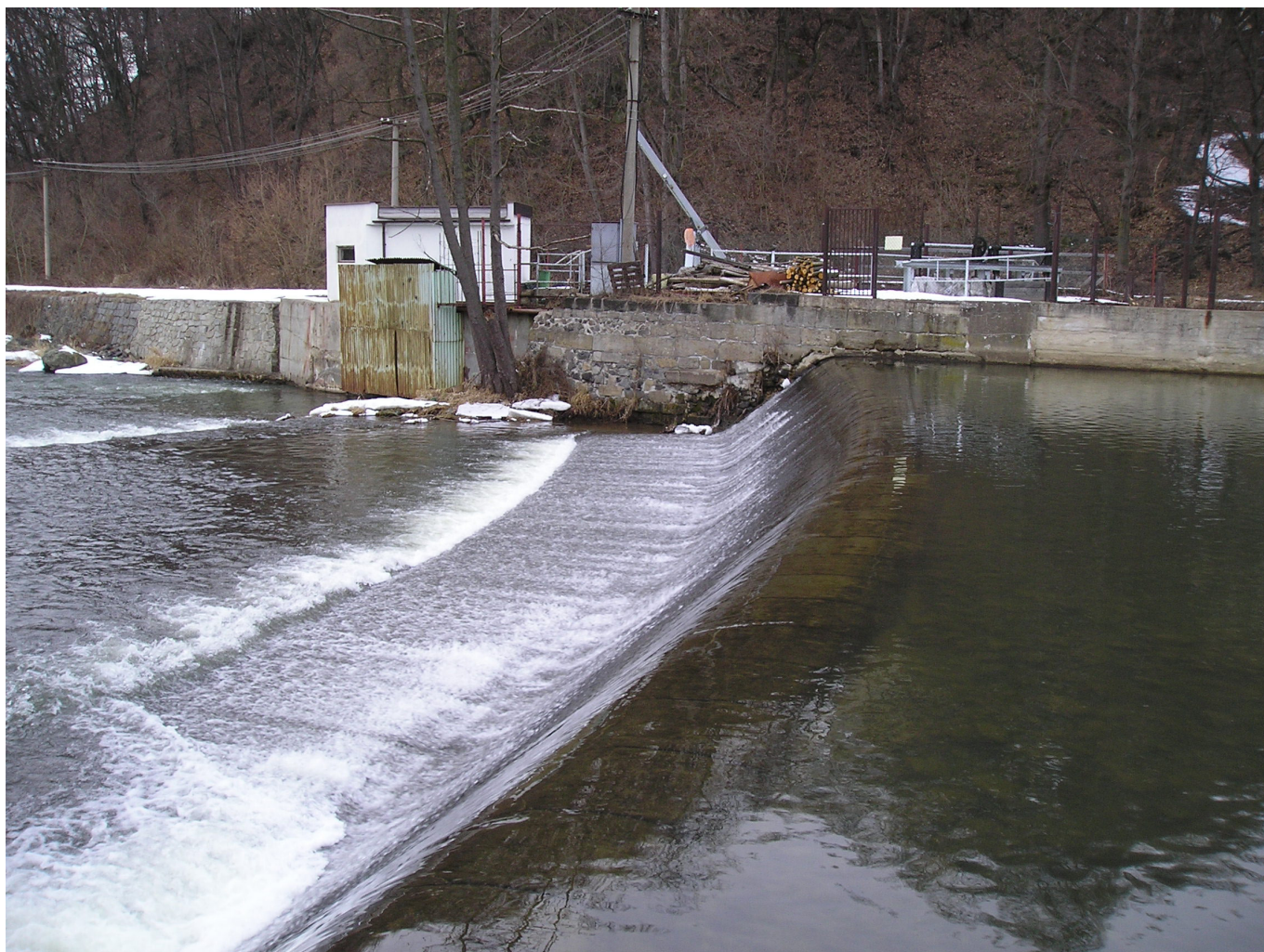
Foto 1: Jez a objekt stávající příjezové elektrárny v Děčíně – Březinách (foto: O. Volf)
