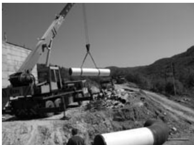
Realizace projektu ZRS Budování páteřního potrubního řádu – rekonstrukce úpravní vody Pečina v západní části Srbska, realizátor VHS Brno, a. s.
