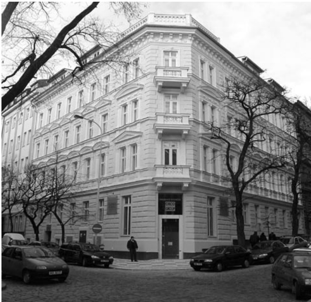
Hotel MaMaison Residence Belgická v Praze. Foto archiv CENIA.
