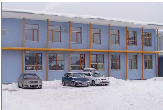
▲ Část školy ve Slivenci po nízkoenergetické rekonstrukci.
