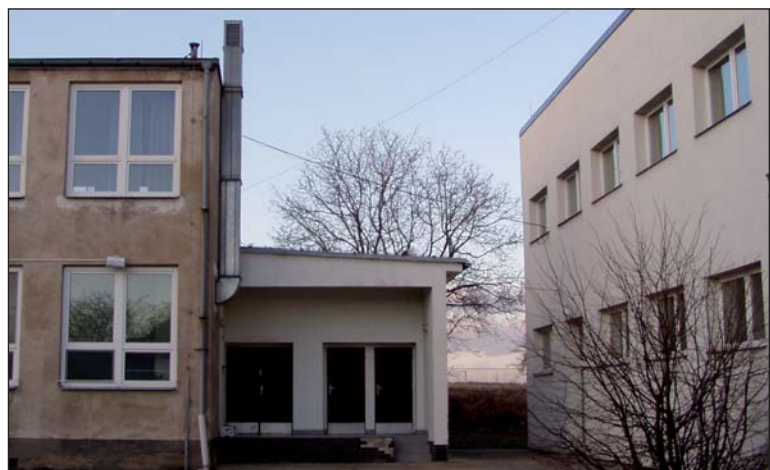
▲ Totéž místo před rekonstrukcí
