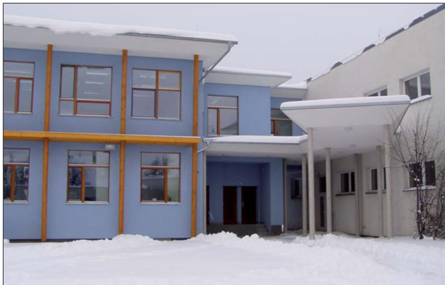
▲ Celkový pohled na nově technicky vybavený a stavebně upravený pavilon.
