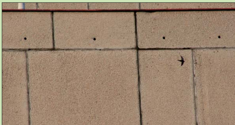
▲ Větrací otvory v podstřeší jsou oblíbeným hnízdištěm rorýsů. Foto Ivan Mikšík
