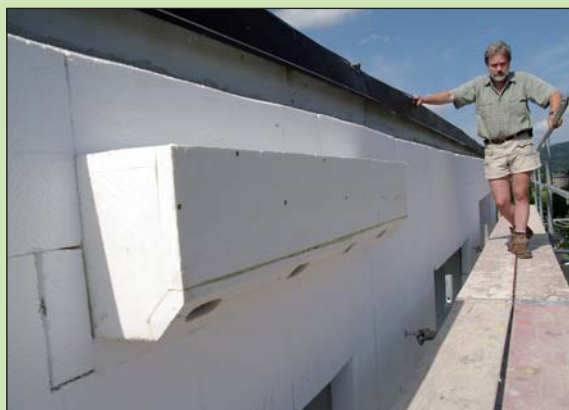
▲ Náhradní hnízdo rorýsů – budka z extrudovaného polystyrenu. Foto Jakub Čejka
