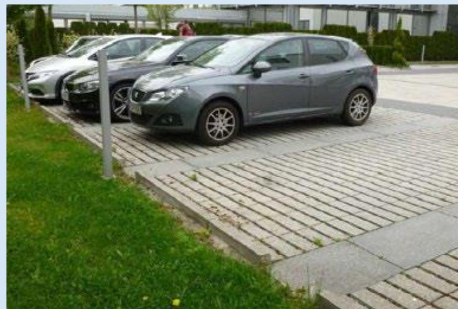
Obrázek 44 Plošný vsak dešťové vody svedený z nepropustných povrchů. Zdroj: Voda ve městě<sup>43</sup>
