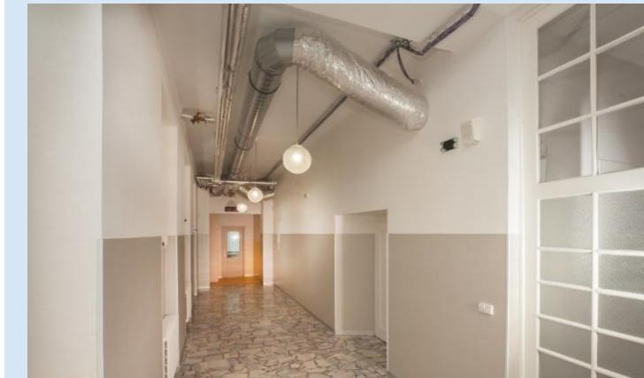
Obrázek 30 Řízená výměna vzduchu s ohrevem, ZŠ Osek nad Bečvou. Zdroj: MŽP.
