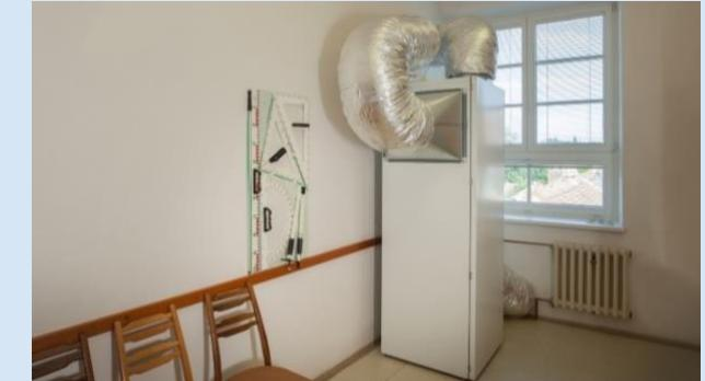
Obrázek 32 Výměník vzduchu na chlazení, ZŠ Jemnice. Zdroj: MŽP
