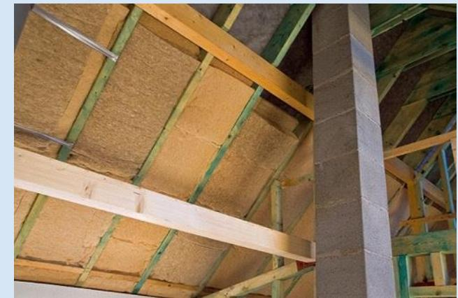
Obrázek 28 Tepelná izolace z technického konopí. Zdroj: <https://www.asb-portal.cz/stavebnictvi/zatepleni/tepelna-izolace-ztechnickeho-konopi-pohled-zhlediska-stavebni-fyziky>
